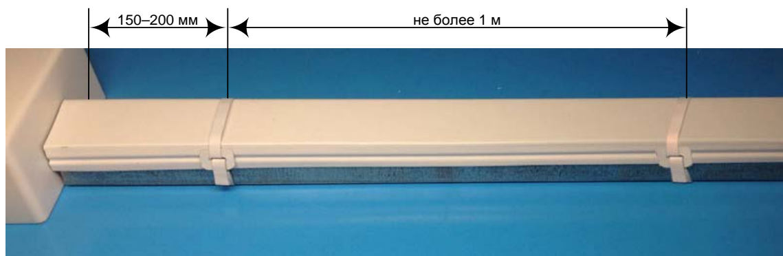
Рис. 7. Фиксация верхней крышки.
